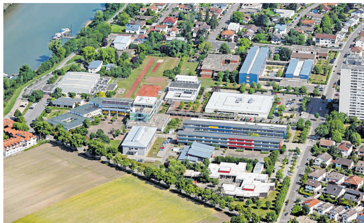
Das Lampertheimer Schulzentrum-West mit Lessing-Gymnasium und Alfred-Delp-Schule.
